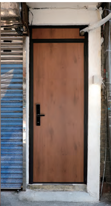
鐵捲門旁小門(開天封同色)
