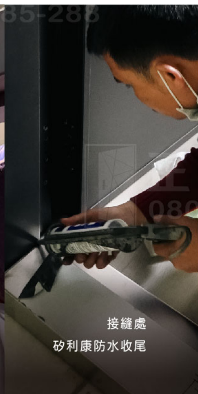
包框門(乾式施工) 現場燒焊及安裝
